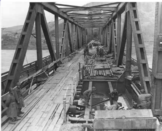
Die Brücke von Remagen, am 17. März 1945 vier Stunden vor dem Einsturz
