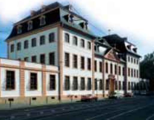
Abb. 3: Der Erthaler Hof in Mainz, Ansicht zur Schillerstraße
